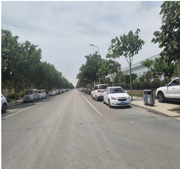
南侧-天工三路
