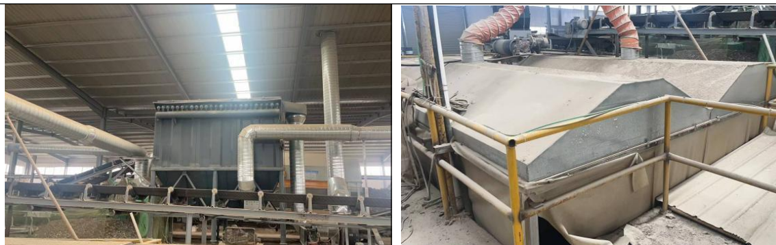
仓筒集气罩+除尘器
