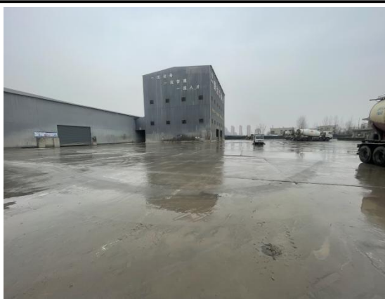
作业区地面清洗
