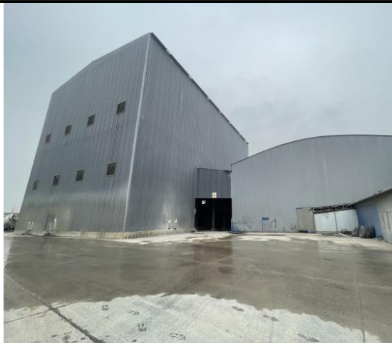
筒仓及搅拌楼密闭设置
