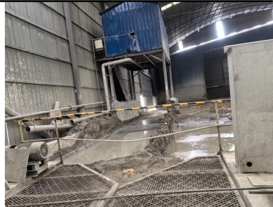
设备清洗废水沉淀池
