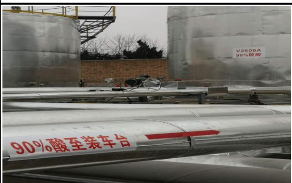
酸储罐区流向标识
