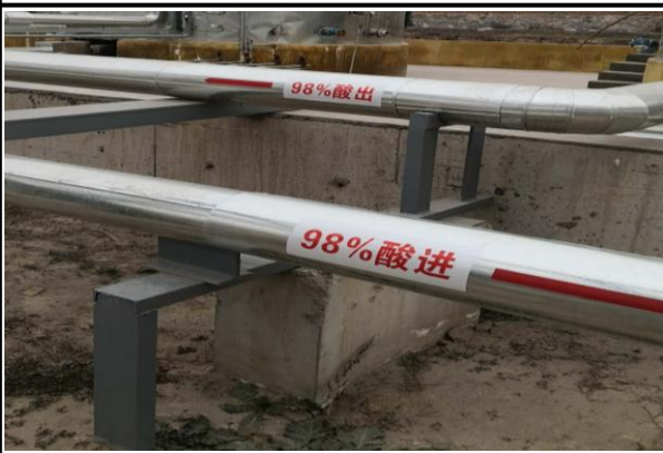
酸储罐区流向标识
