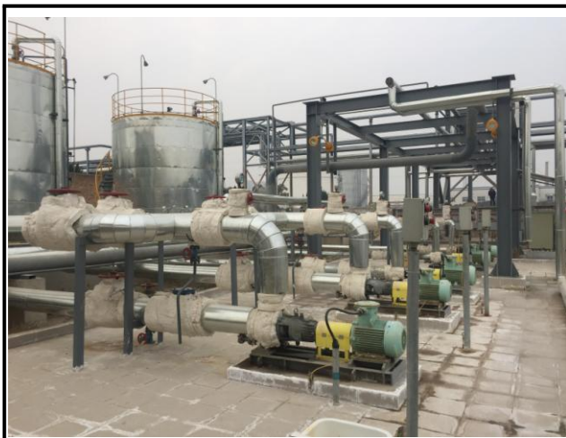
硫酸罐区设备减震及地面防渗
