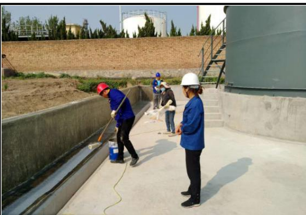
硫酸罐区防渗施工
